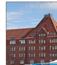
Oppe under tagskægget på Sønderborg Kaserne boede vi en halv snes mand på stuen. Det bastante byggeri var tysk marinestation, opført i 1906.
