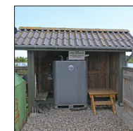
Den nye tank.
